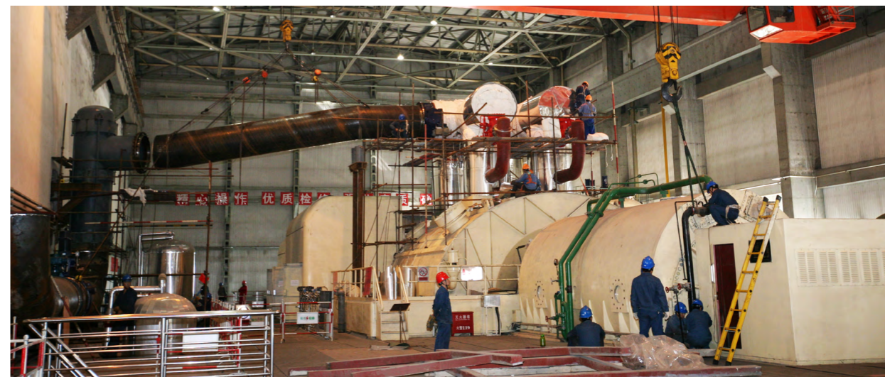
马莲台发电厂机组供热系统改造
