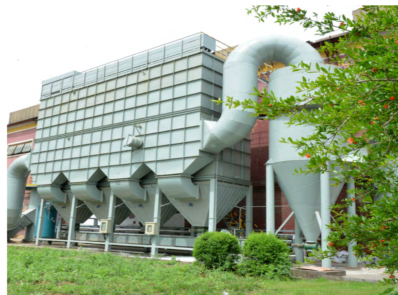
洛阳铜加工新式水平连铸收尘设施投入使用
