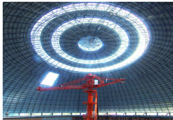
广西分公司华磊热电厂项目建设现场
